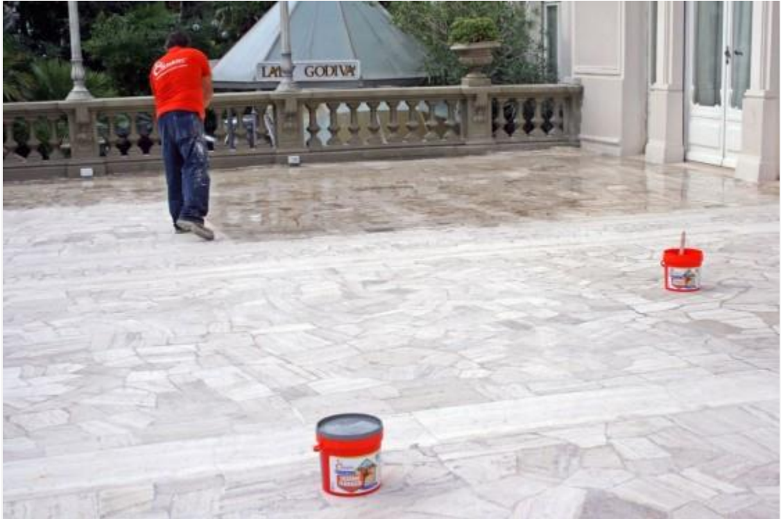
שלב פיזור ה-Winkler Skermo Terrazze על גבי הריצוף (צולם ע"י Winkler Chimica)
